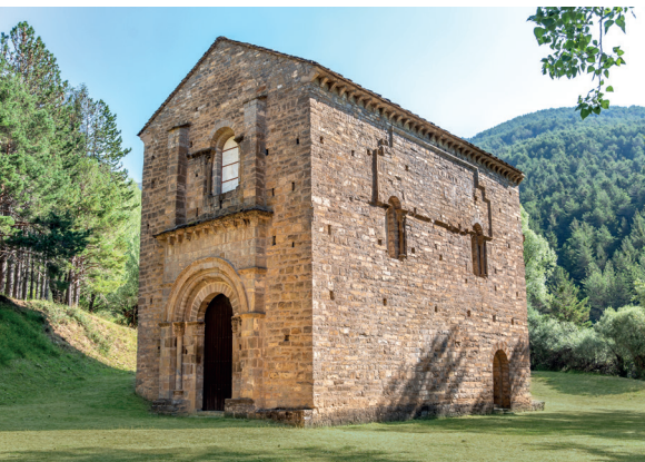
➤ Las construcciones románicas, como la de Santa María de Iguácel presentan gruesos muros y escasos vanos, para invitar al recogimiento y la oración.
